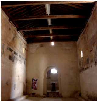
Vista general del interior de la nave
