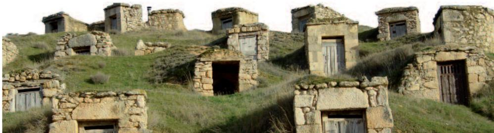
Las bodegas subterráneas conforman conjuntos arquitectónicos constituidos por varias decenas e, incluso, por más de un centenar de ejemplares, localizados a las afueras de los núcleos de población ribereños. Se trata de galerías para la conservación del vino, excavadas en el subsuelo, aprovechando la existencia de estratos arcillosos consistentes e impermeables.
